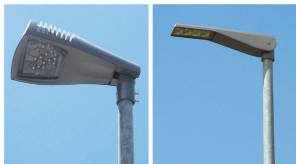
Moderne LED-Technik mit warmweißen LEDs
